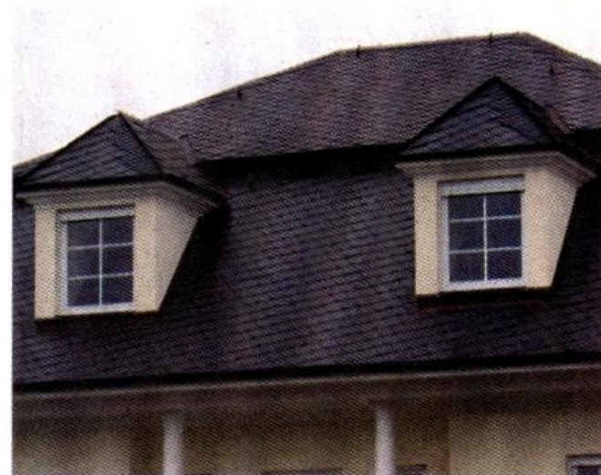
Ein neues Dach mit Eternit-Baustoff.
